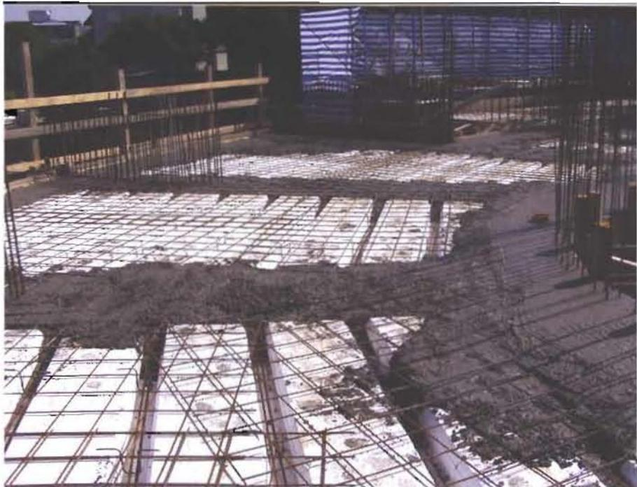
A differenza di un solaio tradizionale inoltre, non è stato prodotto materiale di scarto durante la posa dei pannelli eludendo così possibili problemi di stoccaggio in cantiere e di smaltimento dello stesso con un risparmio notevole in termini di tempo e di costi
