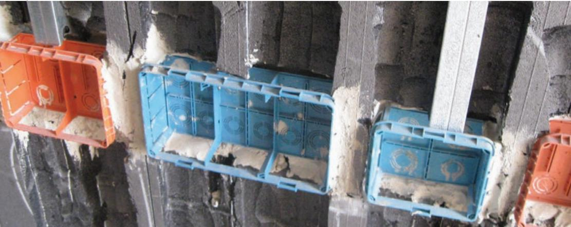
Impiantistica tracce sul pannello interno del muro
