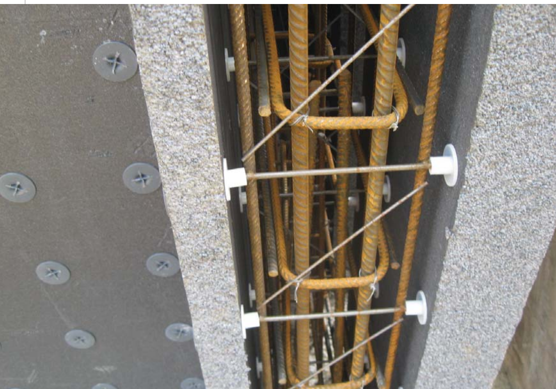
Armadura integrativa aperture
