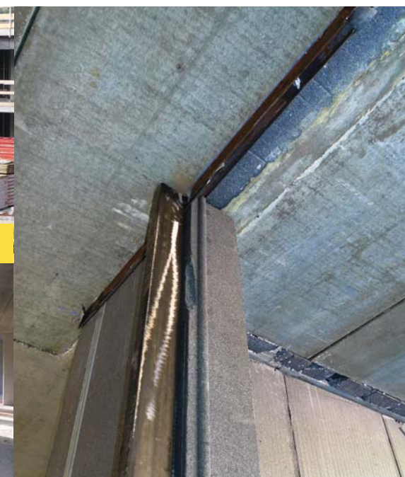
Particolare del telaio per gli infissi
