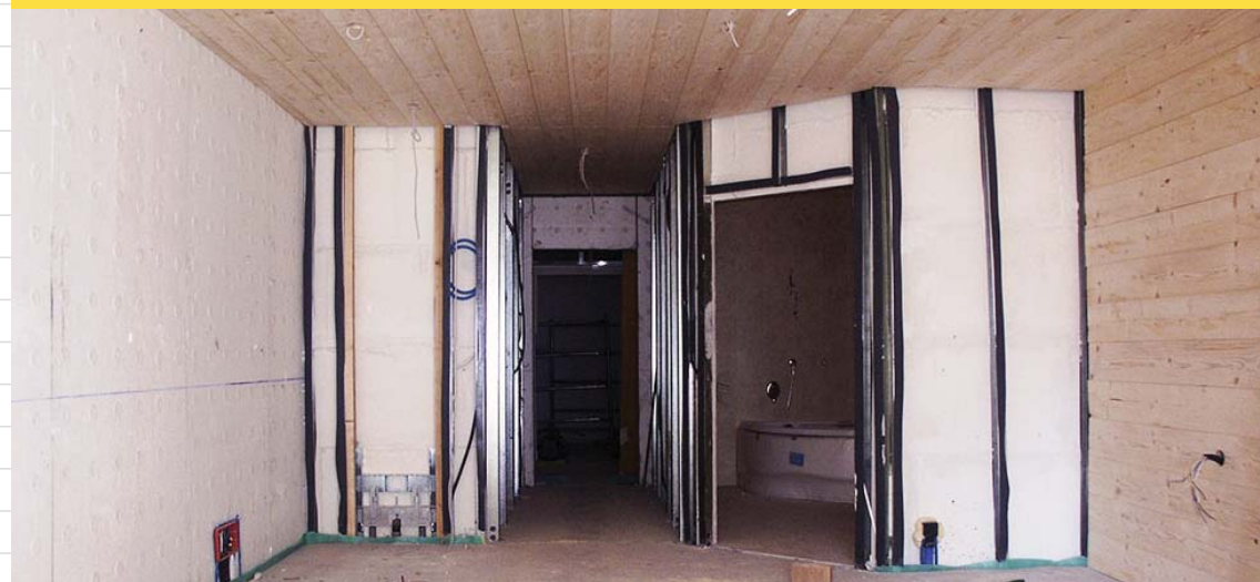
Controsoffitto in legno
