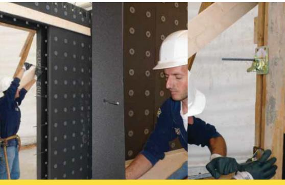
Posizionati i casseri **PLASTBAU®** 3 nelle canaline, collegati gli stessi con armature orizzontali, posizionati gli angoli, le spalle e bloccate le aperture e gli angoli con le opportune cravattature, occorre, come ultimo intervento prima di effettuare il getto, metterli a piombo operando secondo prassi.
