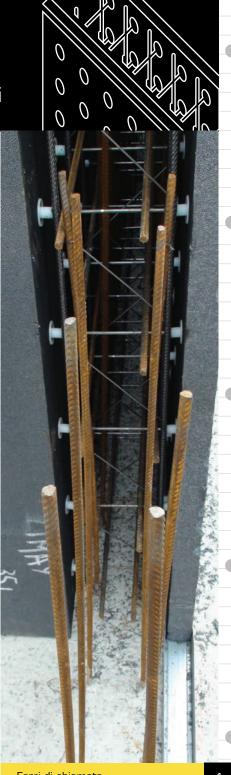
una volta maturata la soletta orizzontale, i ferri verticali saranno saldamente ancorati e quando il cassero muro sarà posizionato, calandolo dall'alto verso il basso, essi, infilandosi nello spazio tra le due lastre in EPS, si affiancheranno ai Ø 08/10 verticali dei tralicci costituenti l'armatura del cassero stesso.
