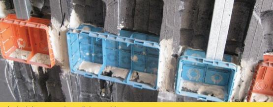
Impiantistica tracce sul pannello interno del muro
