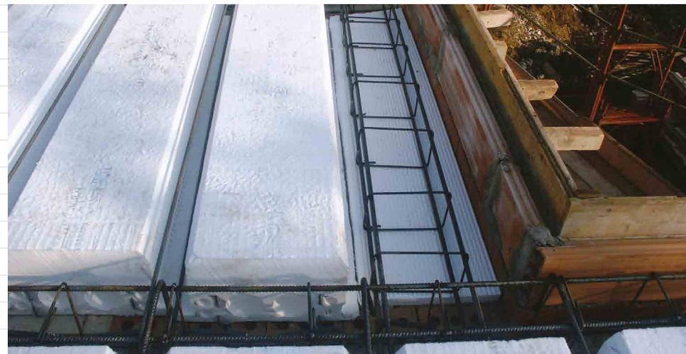
Questa permetterà di avere lastre dritte con i bordi perfettamente paralleli e di eliminare quasi totalmente gli sprechi, avendo appunto la possibilità di accostare una lastra all'altra fino al raggiungimento della larghezza desiderata. Abbinato al cassero-solaio **Plastbau® Metal** elimina i ponti termici del solaio in corrispondenza delle travi.
