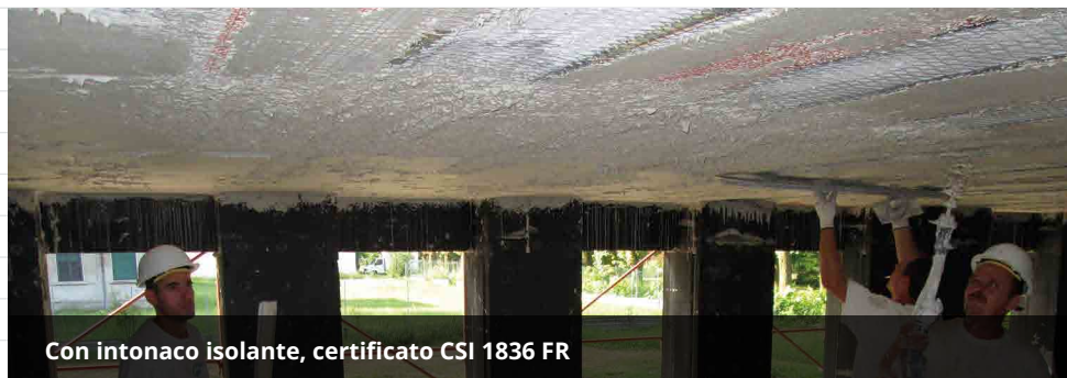
CONTROSOFFITTO SU STRUTTURA METALLICA CON PRESTAZIONI REI
